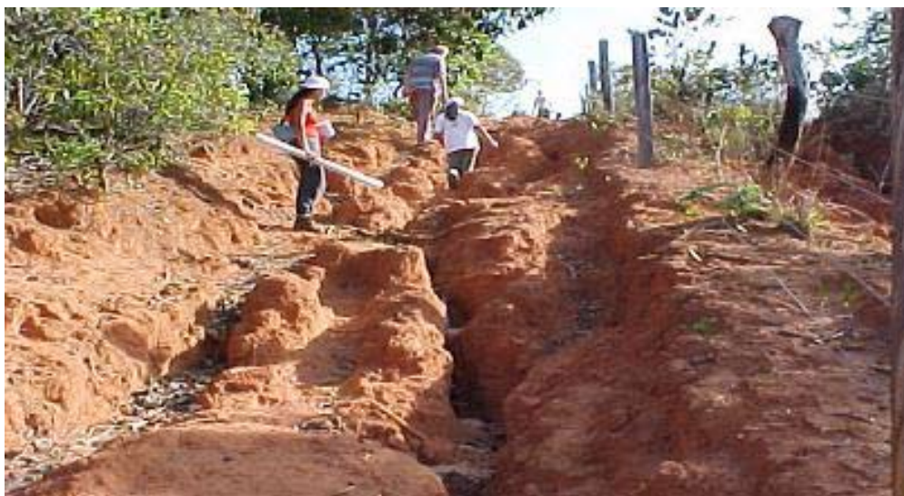
Figura 5.8 – Erosão linear na forma de ravina, causada pelo escoamento concentrado das águas da chuva ao longo de uma cerca
